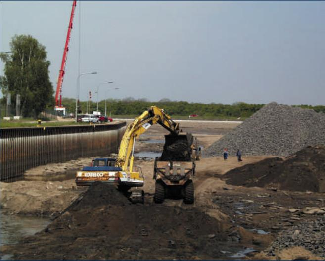
Abb. 4 Erneuerung der Sohlbefestigung im oberen Vorhafen während der Reparaturarbeiten
