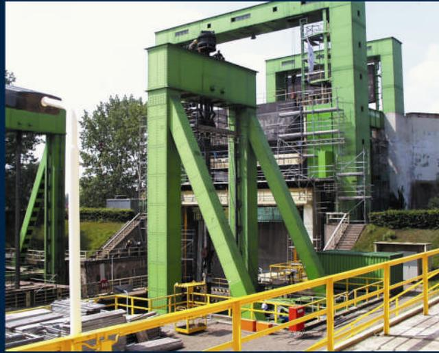
Abb. 1 Blick auf die Führungsgerüste des Troges mit gezogener Spindel (im Vordergrund)
