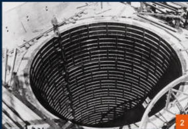
Abb. 3 1936 - Der Schacht ist fertiggestellt und die Schwimmerführungsschienen montiert.
