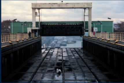
Abb. 4 Entleerter Trog während der Reparatur
