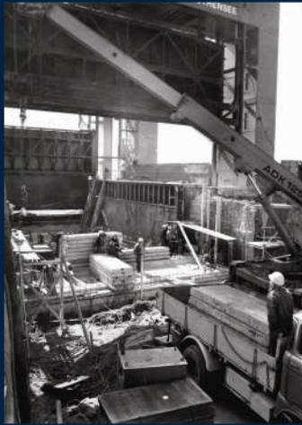
Abb 3 Betonerneuerung an der Dammabschlußmauer im Bereich des Sicherheitstores
