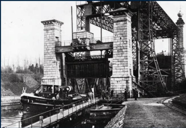
Abb. 1. Altes 5-Schwimmer Hebewerk in Henrichsburg, erstes Schwimmerhebewerk in Deutschland und heute technisches Denkmal
