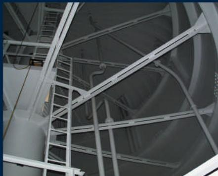
Abb. 2. Innerer Korrosionsschutz der obersten Schwimmerzelle nach der Instandsetzung
