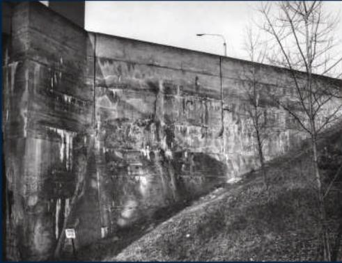
Abb 1 Zustand der Flügelmauer vor der Generalreparatur
