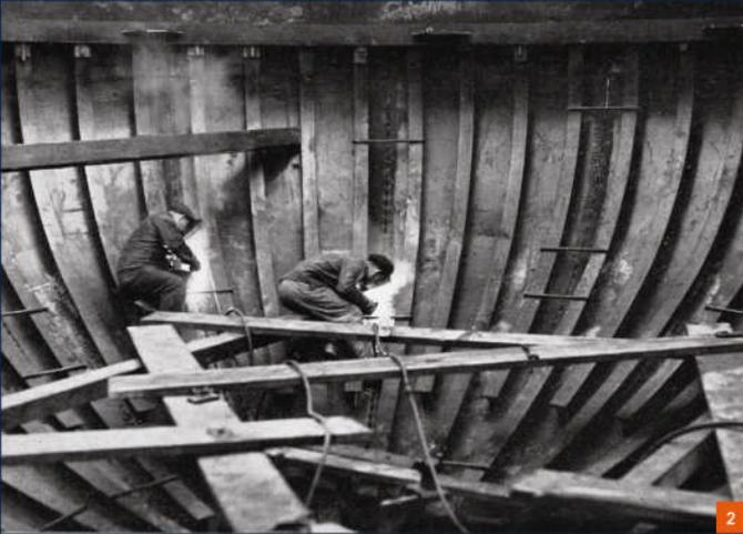
Abb. 4 1936 - Arbeiter schweißen die Wanne des Schwimmers.
