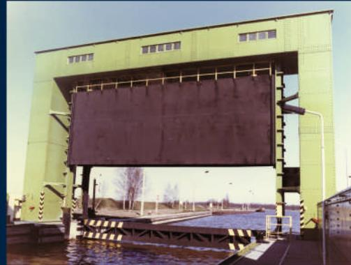
Abb 4 Sicherheitsportal mit Sicherheitstor und Stoßbalken nach Inbetriebnahme
