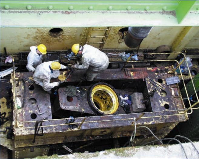
Abb. 1: Mutterantriebsblock am Trog mit kardanischer (allseitig beweglich) Lagerung der Mutterführung während der Demontage
