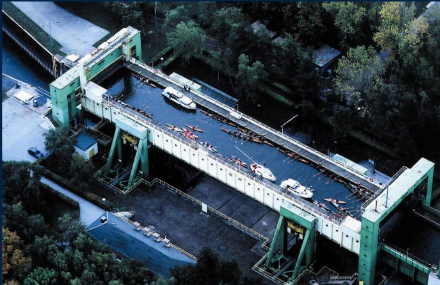
Abb. 1 Blick auf das Schiffshebewerk in Rothensee. Hier können Schiffe vom Mittellandkanal zum Hafen Magdeburg und zur Elbe "absteigen". Ein Umlaufspiel mit einem Schiff aufsteigend und einem zweiten Schiff absteigend dauert etwa 40 Minuten. Die reine Fahrzeit des Troges dauert dabei nur 3 Minuten, ein Aufstieg in der Schleuse dagegen ca. 25 Minuten.
