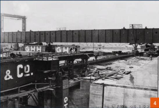
Abb. 4 1937 - Der Trog hatte jetzt die Höhe erreicht, so dass er am Ende der unteren Schienenlaufbahn im Bereich der Trogkammer auf eine höhere Schienenlaufbahn weiterbewegt werden konnte.
