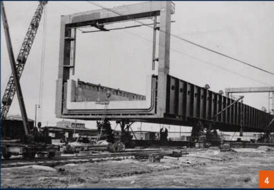
Abb. 5 1937 - Die Vormontage des Troges ist abgeschlossen. Die Trogportale sind ebenfalls montiert. Die gesamte Trogkonstruktion wurde aufgepalmt. Auch der Dichtungsrahmen ist montiert. Zum damaligen Zeitpunkt waren die Führungsschienen vom Portal und der Trogwanne noch nicht miteinander verbunden.
